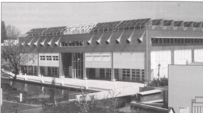
Bild 1 Ansicht auf das Gebäude der Abteilung Elektrotechnik der HTA Burgdorf mit dem Solargenerator (60 kW p ) der PV-Testanlage. Eine Eisenbahn-Hauptstrecke führt etwa 10 m hinter dem Aufnahmestandort durch.
