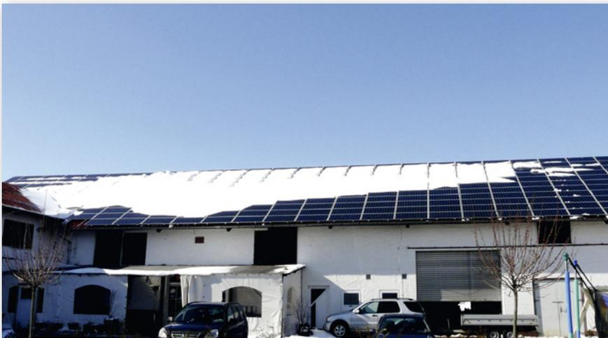
Abbildung 9: Durch Schneeräumversuche auf PV-Anlagen sind schon schwere Unfälle geschehen: Besser warten, bis es taut und der Schnee abrutscht. Betreten Sie schneebedeckte Dächer keinesfalls ungesichert!
