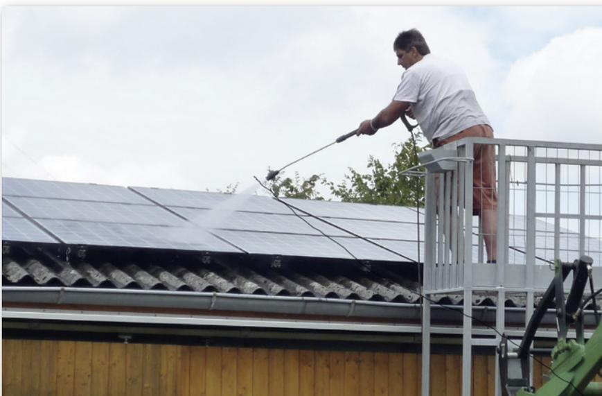
Abbildung 10: Ein sicherer Arbeitsort: Vom Arbeitskorb aus können Reinigungsarbeiten der PV-Anlage erledigt werden ohne auf das Dach zu steigen
