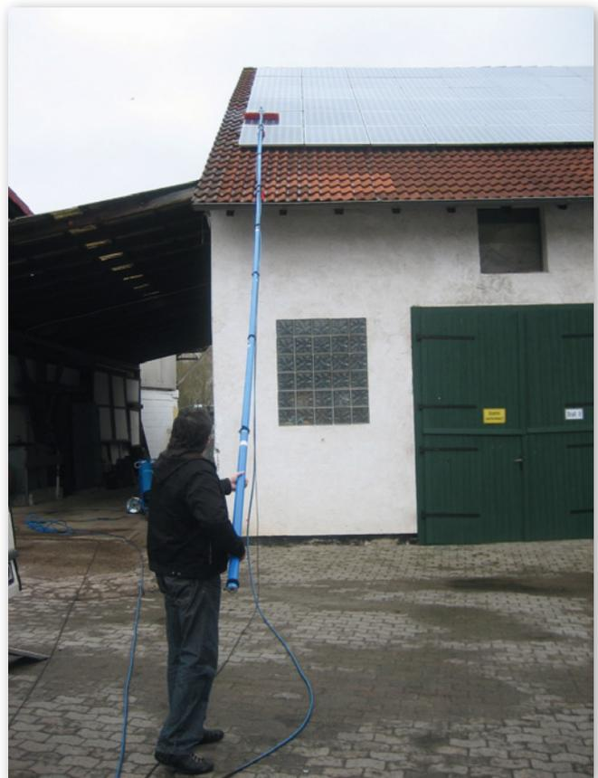
*Abbildung 11: Bei der Reinigung von Photovoltaikanlagen ist auf die Sicherheit zu achten. Mit einer ausziehbaren Teleskopstange können die Module vom Boden aus gereinigt werden. Somit wird die Gefahr eines Absturzes vom Dach ausgeschlossen und einen Stromschlag zu erleiden deutlich minimiert*
